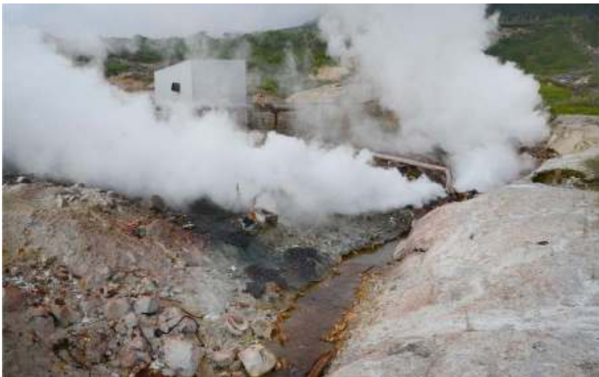
Рис. 199. Парогидротермы ГеоТЭС «Океанская», сбрасываемые в ручей Старозаводской, изменяют его физико-химические свойства. Фото автора, 2013 год.
