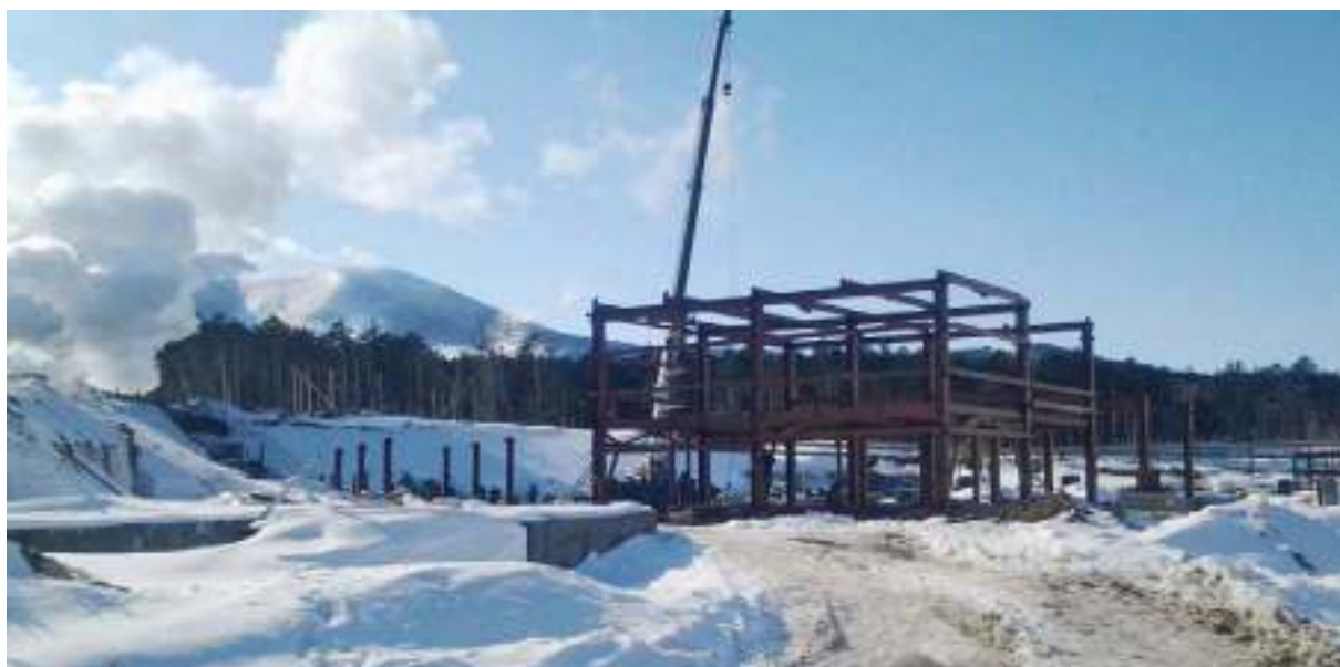
Рис. 363. Строительство на ГеоТЭС «Менделеевская». Фото И.М. Климанцова, февраль 2014 года.
