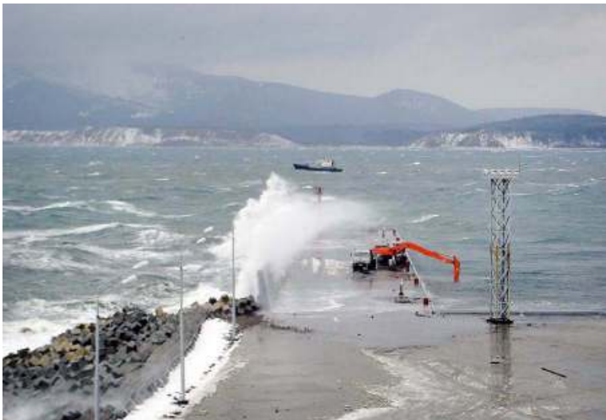
Рис. 364. Строительство причального комплекса на о. Кунашир. Фото И.А. Неведомской, 2010 год.
