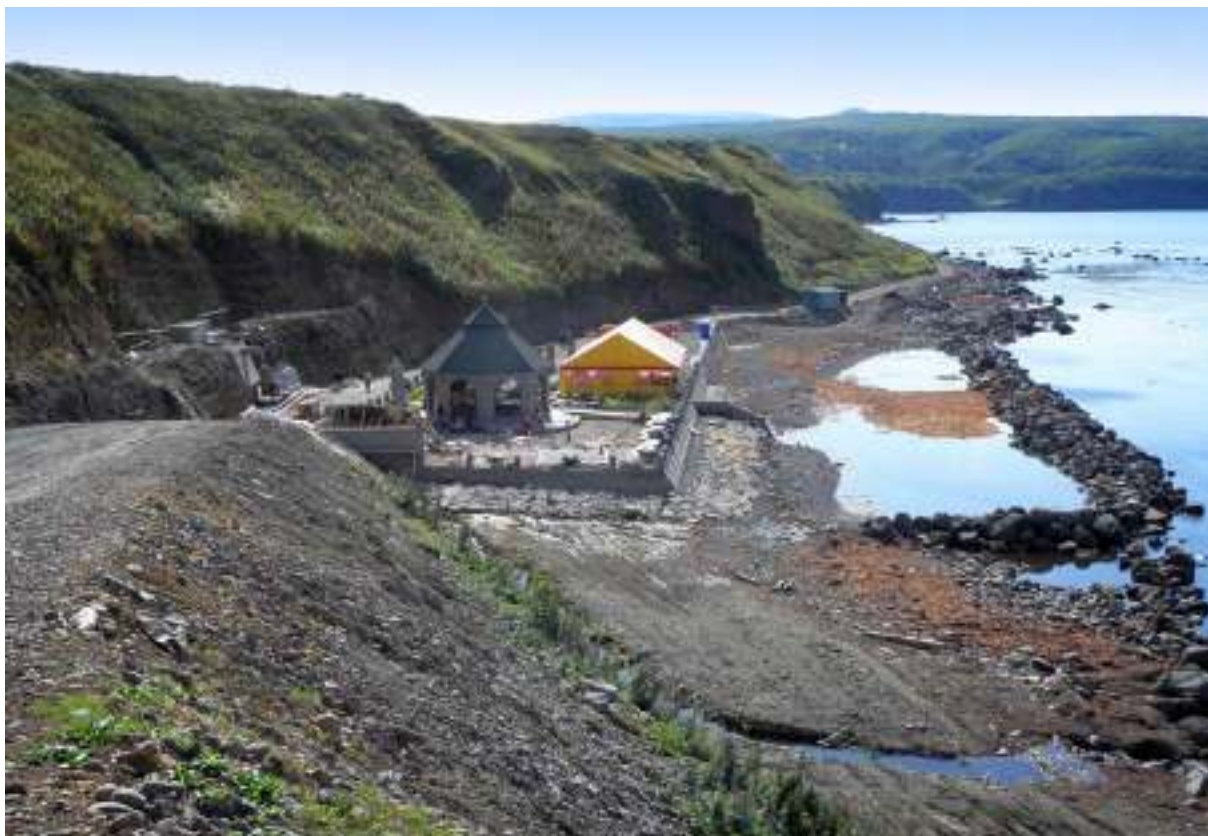
Рис. 150. Строительство ЗАО «Гидрострой» купального комплекса в районе г. Курильск. Фото А.В. Дегтерева, 2009 год.
